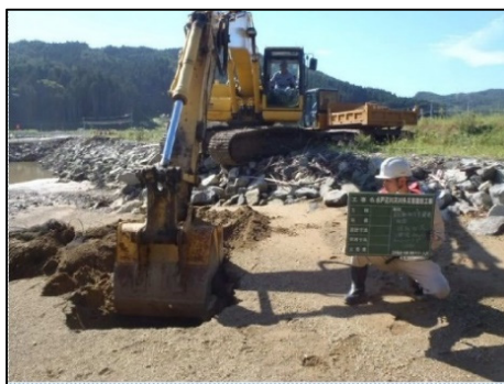
写真 4-7-1 移植作業状況【水戸辺海岸】
