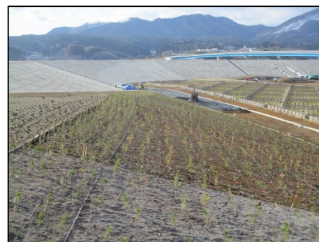
再移植後の状況（南側法面）
