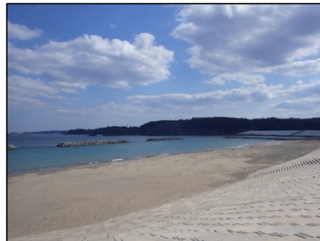
工事完了後の中島海岸
