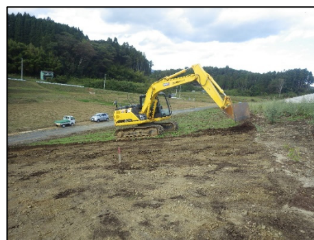
バーク材の撤去作業
