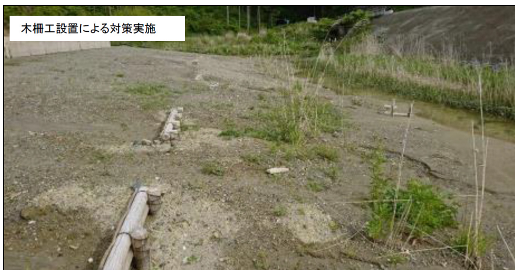
写真 4-2-16 木柵工設置による土砂流出対策【津谷川】
