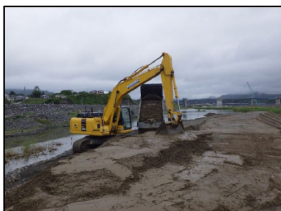
盛土作業状況
