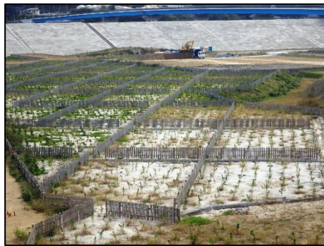
左岸植栽地の状況（令和2年10月）
