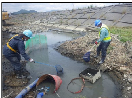
写真 4-2-10 底生動物・魚類の採捕・移植状況【津谷川】
