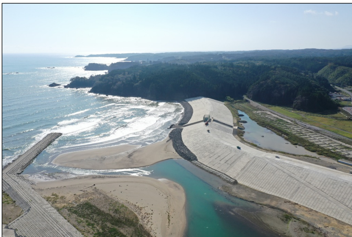
写真 4-2-20 津谷川河口部の状況（令和 2 年 10 月 2 日）【津谷川】
