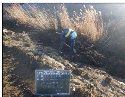
ヨシ原植え付け作業状況
