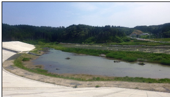
整備後の右岸湿地
