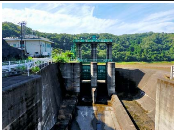
樽水ダム常用洪水吐
