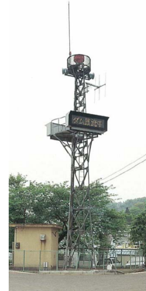
管理設備費(警報局) 大倉ダム:仙台市
