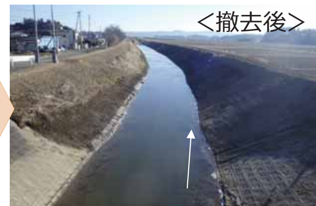
土砂撤去 （流下能力の改善）
