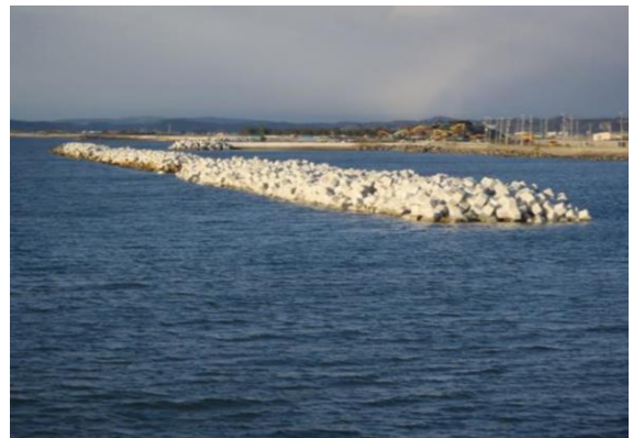
西浜南浜地区海岸（石巻市）
