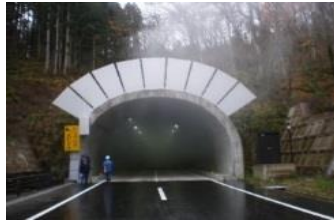
国道108号 荒雄湖トンネル (大崎市)
