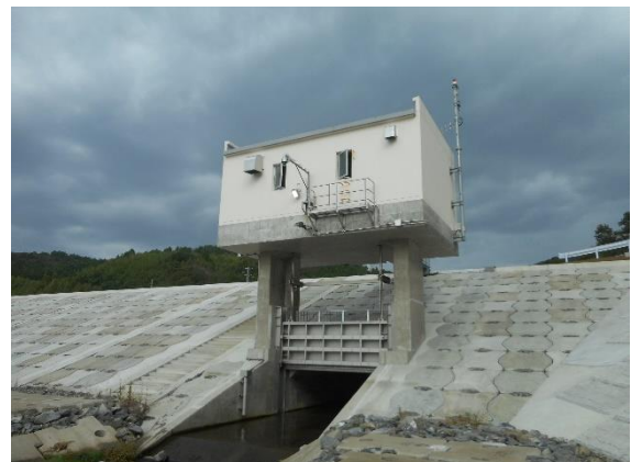
白浜第1水門（石巻市）
