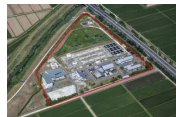
大和浄化センター(大和町)
