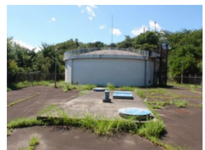
桔梗平配水池（大衡村）
