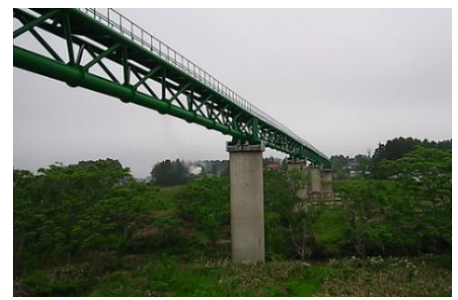
北屋敷水管橋 (大崎市)
