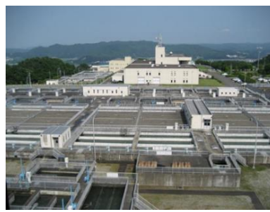
南部山浄水場 (白石市)
