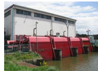
田尻排水機場（大崎市）
