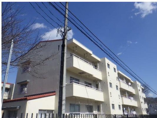
広瀬住宅（仙台市）
