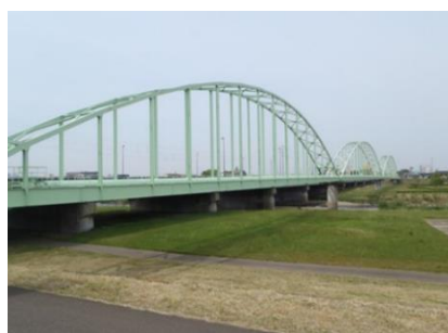
広瀬川水管橋（仙台市）
