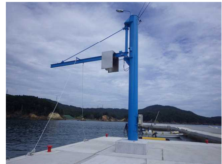
荷揚げクレーン
