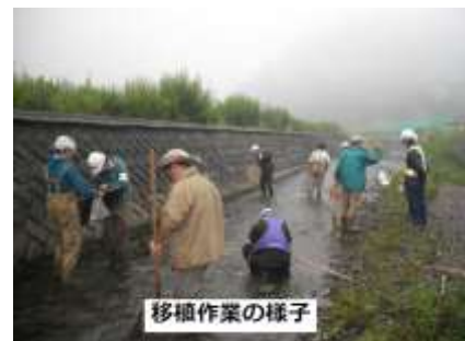
写真 5.3 環境に配慮した工事の取組事例 (カンキョウカジカの移植作業，宮城県河川課，2015年度)
