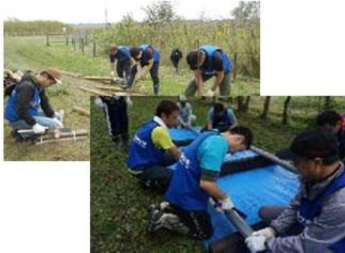
沼を周遊する散策路整備に用いる資材の加工
