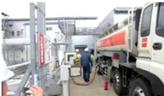
防火面、作業安全面を含めた納入作業の点検
