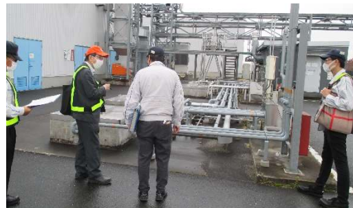
設備の現地確認
