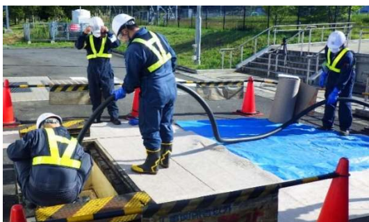
土壌浸透防止の養生をした廃液引抜き作業の点検
