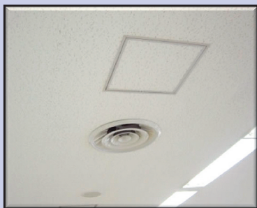
石綿含有ロックウール吸音天井板
