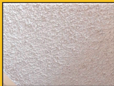
石綿含有パーミキュライト吹付け (天井断熱材・吸音材・結露防止用)
