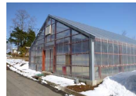
少花粉スギ苗木増産のための施設整備（ミストハウス）
