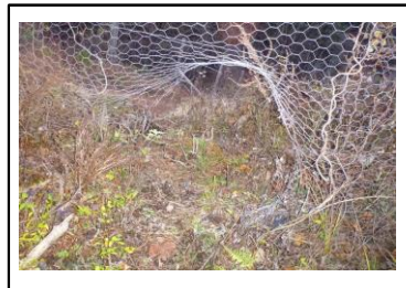
破損した防鹿柵
