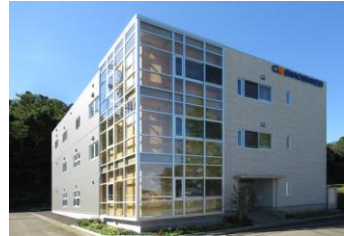
【事例】株式会社コスモスウェブ（社屋） 県内初の3階建CLT建築 CLTパネル工法（ルート2）
