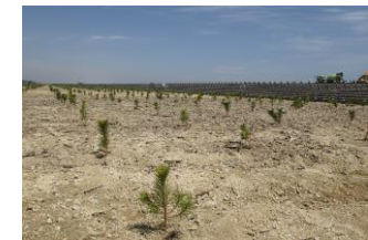
海岸防災林の復旧
