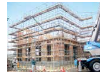
CLTを使用した木造建築物
