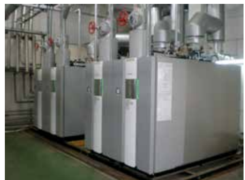
▲ H30：奥側2台のボイラーを更新
