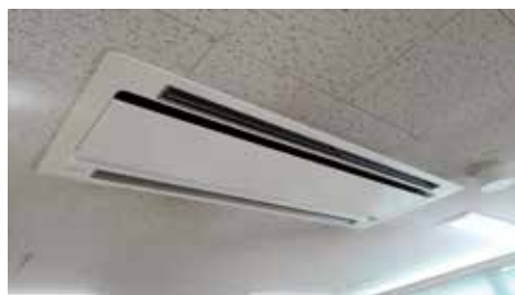
▲更新エアコン
