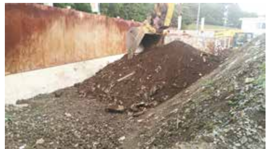
▲選別前の土砂系混合物
