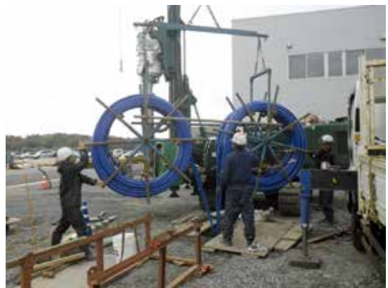
▲地中熱交換器施工状況
