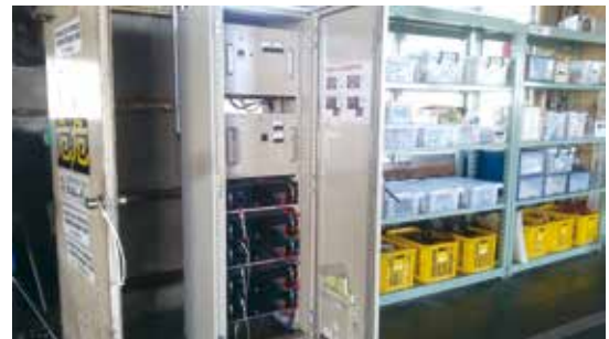
▲リチウムイオン蓄電システム (夜間・ピークカット対応)
