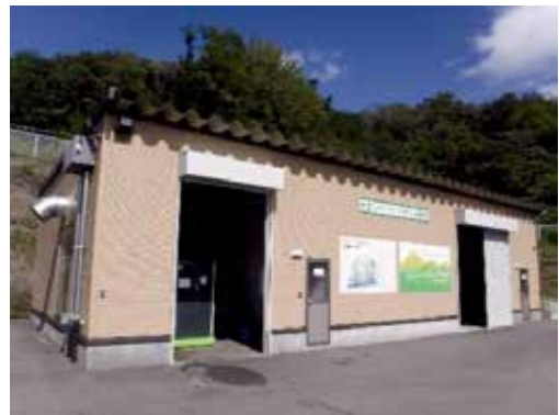
▲木質バイオマス発電施設全景
