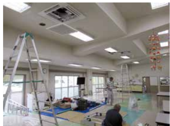
▲食堂ホールエアコン更新工事
