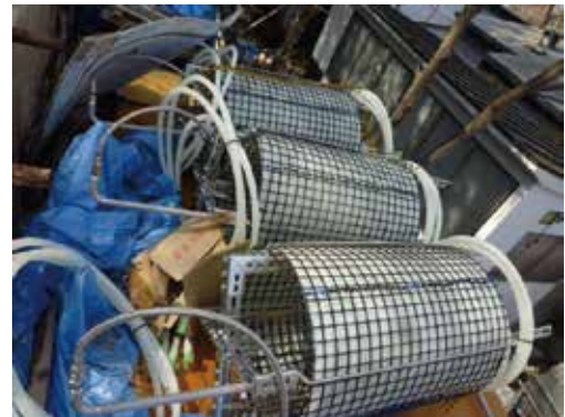
▲導入した樹脂管製熱交換コイル
