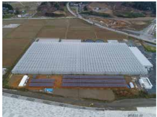
▲太陽光発電（営農型）施設配置状況
