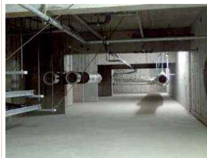
▲地下ピット設置状況
