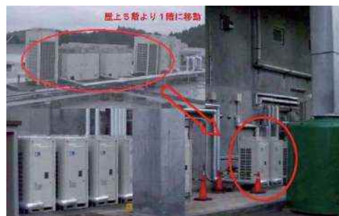
エアコン室外機の移設対応
