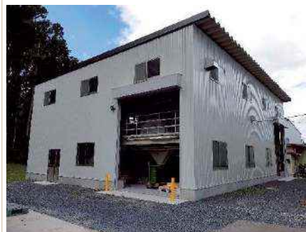
▲排水処理設備外観
