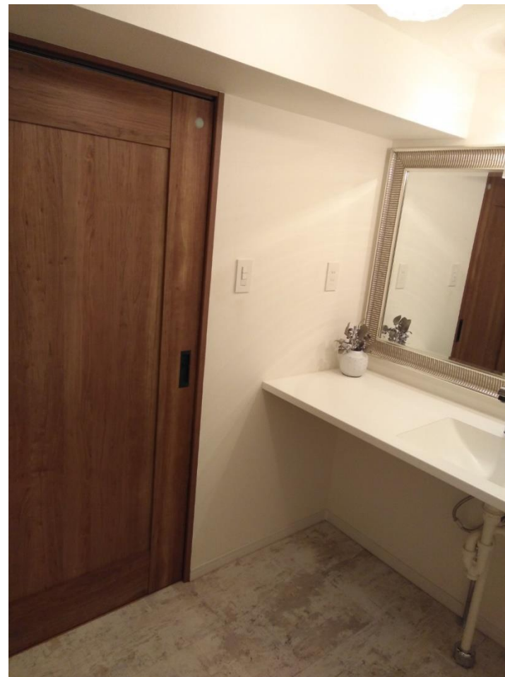
出入口を開き戸から引き戸に交換
