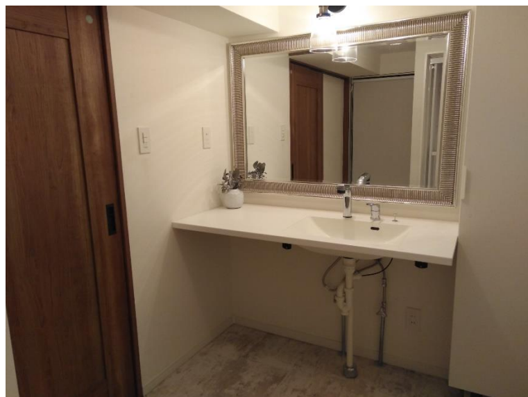
洗面台の交換（下部空間を確保）
