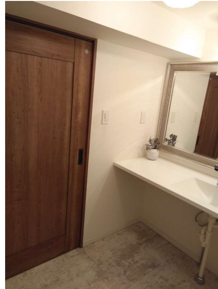
出入口を開き戸から引き戸に交換
