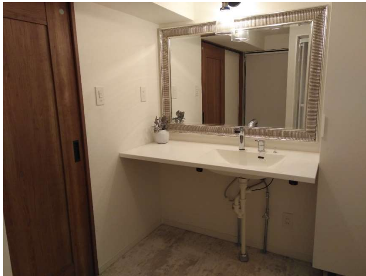
洗面台の交換（下部空間を確保）
