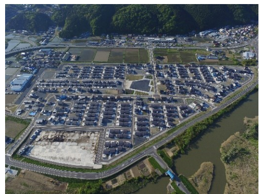
石巻市の防災集団移転事業 （二子地区）
