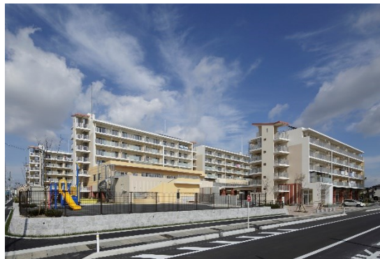
多賀城市営災害公営住宅（桜木地区） 保育所併設型
