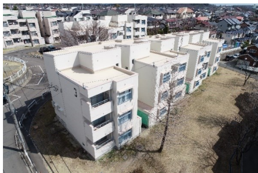
県営住宅桜ヶ丘3号棟 外壁断熱改修（施工後）
