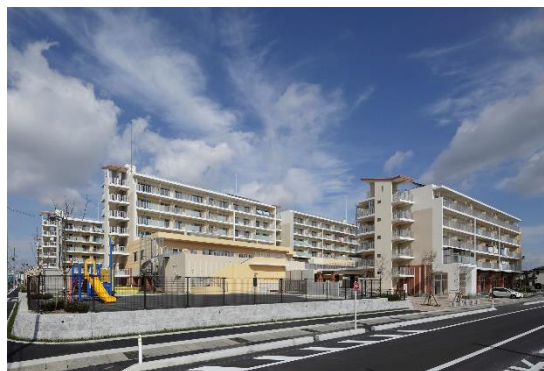
多賀城市営災害公営住宅（桜木地区）
