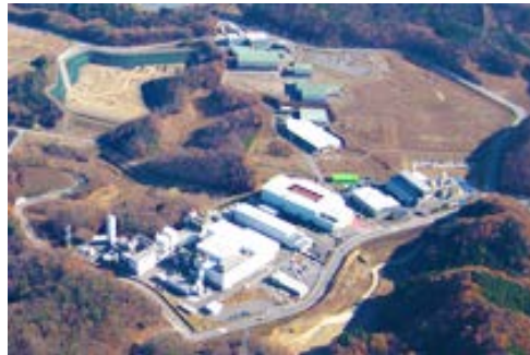
事業基盤施設整備＋公園緑地施設整備 (BT0)
