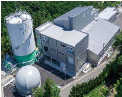
乾式メタン発酵施設
