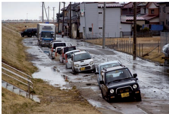
図 2.3.6 液状化の状況（名取川周辺）
