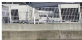
(電気設備の移設)
