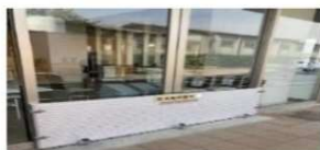
(止水板の設置)
