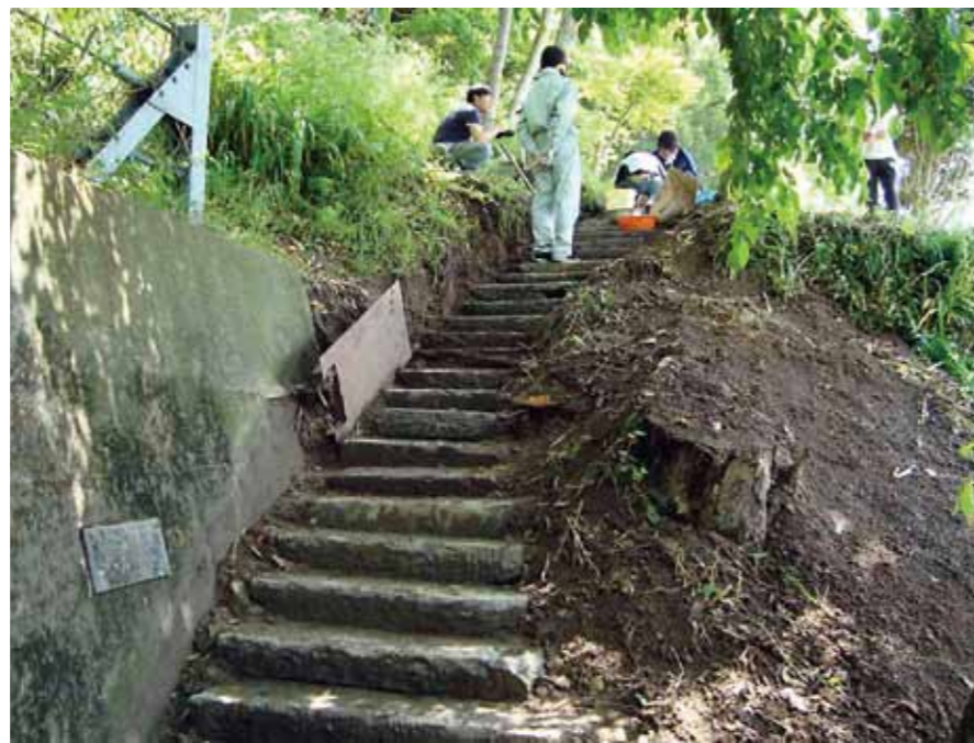
完成した避難路
