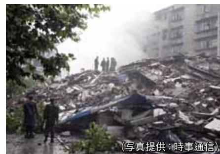
地震による被害状況
