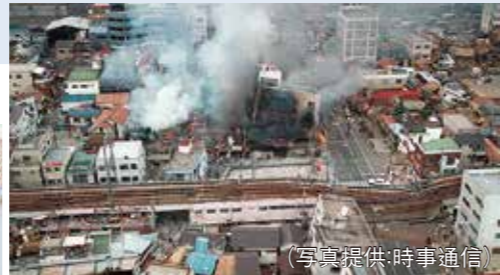
阪神・淡路大震災の被害
