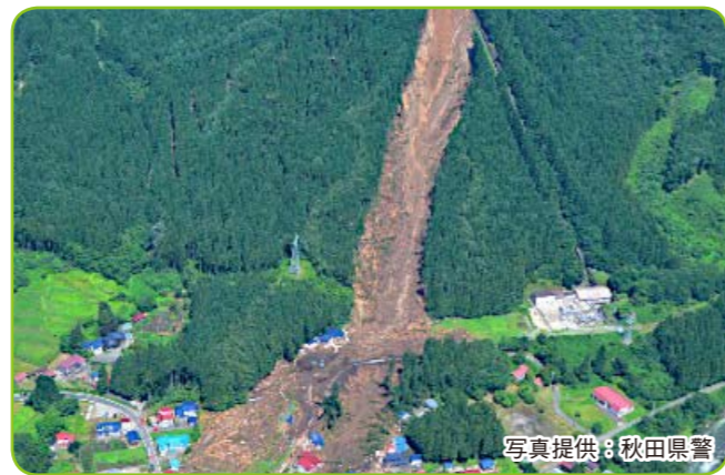
△雨でくずれた土砂
