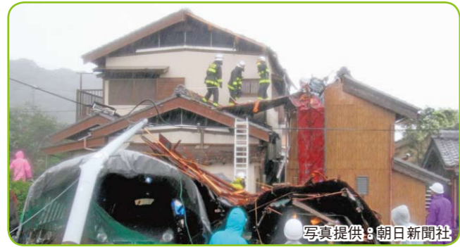
△風でたおれ、折れ曲がった電柱
