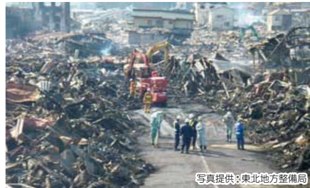
▲ 消防本部、建設業者によるがれきの撤去作業
