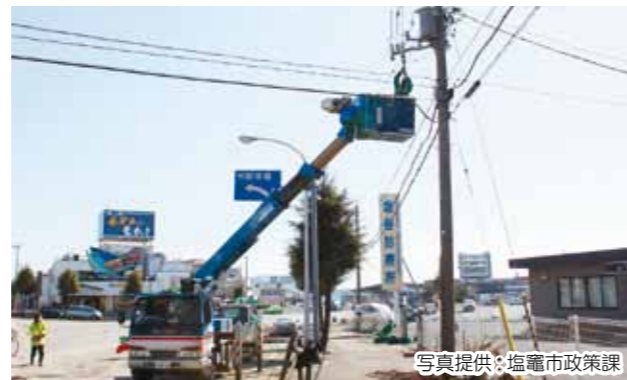
▲ 電力会社による電気の復旧作業
