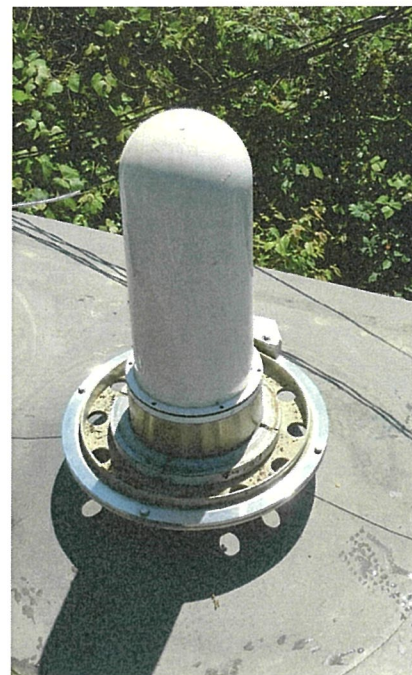
④鉛遮へい取り外し後
