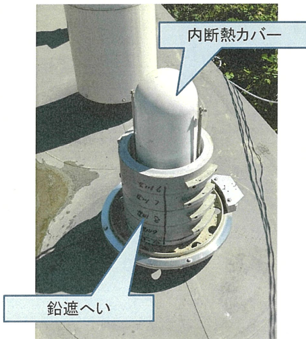
③鉛遮へい取り外し中
