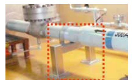
設備の耐震化(配管を支える装置の増強)
