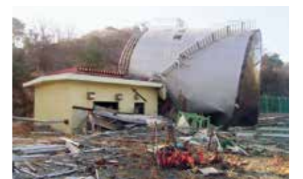
震災時の様子(重油タンクの倒壊)
