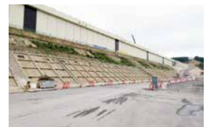
防潮堤かさ上げ工事の様子(平成29年9月撮影)
