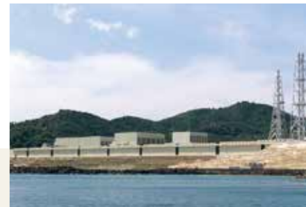
防潮堤のかさ上げ工事が進められている女川原子力発電所 (写真提供 東北電力株式会社)
