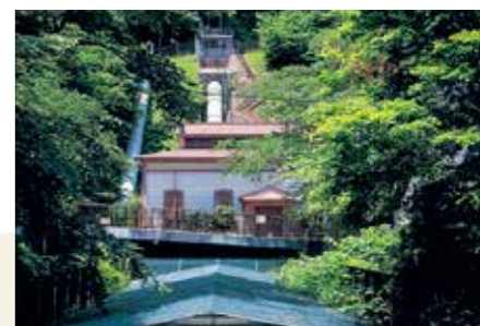
広瀬川の水を動力に発電を続ける三居沢発電所 (写真提供 東北電力株式会社)
