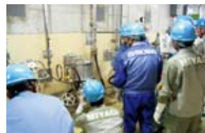
現場確認(3号機)
