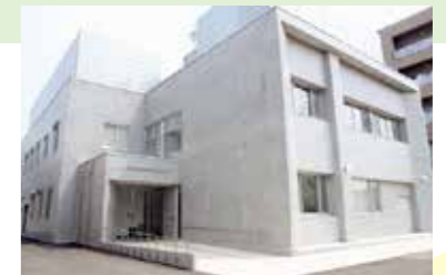
④ 環境放射線監視センター再建
