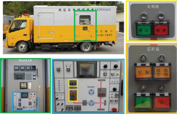
電源車側面 操作盤
