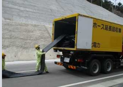
ホース敷設, 接続
