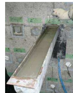
③孔内に確実にモルタルが充填されるように養生を行う
