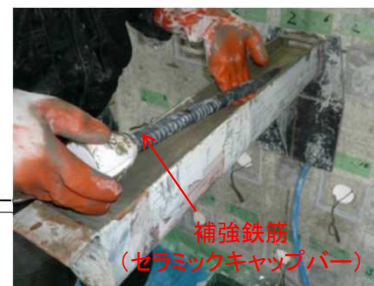
②補強鉄筋(セラミックキャップバー)を差し込む
