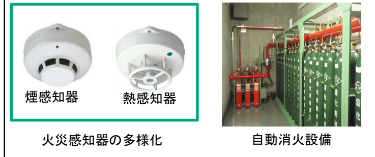
[火災の感知・消火対策の例]
