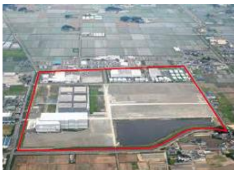
貸付金を活用して造成した工業用地 （巨理中央地区）
