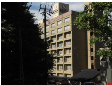
耐震改修完了（鳴子ホテル）
