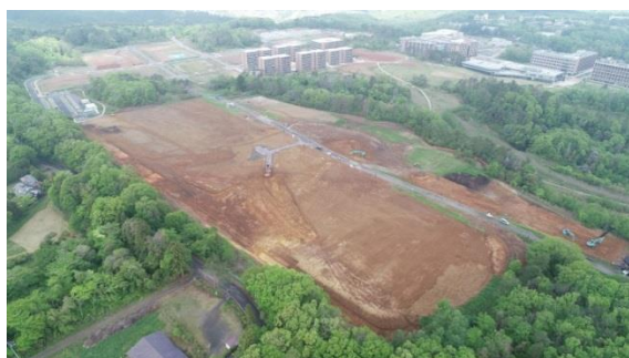
敷地造成工事施工状況
