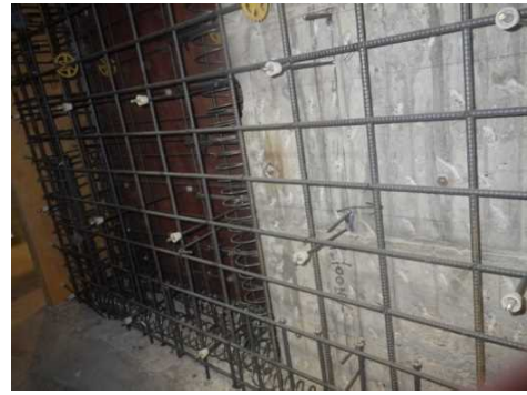
改修工事の施工状況
