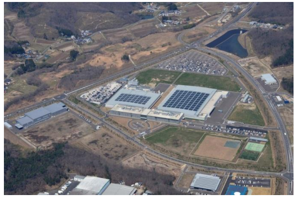
東京エレクトロン宮城株式会社 (大和町)
